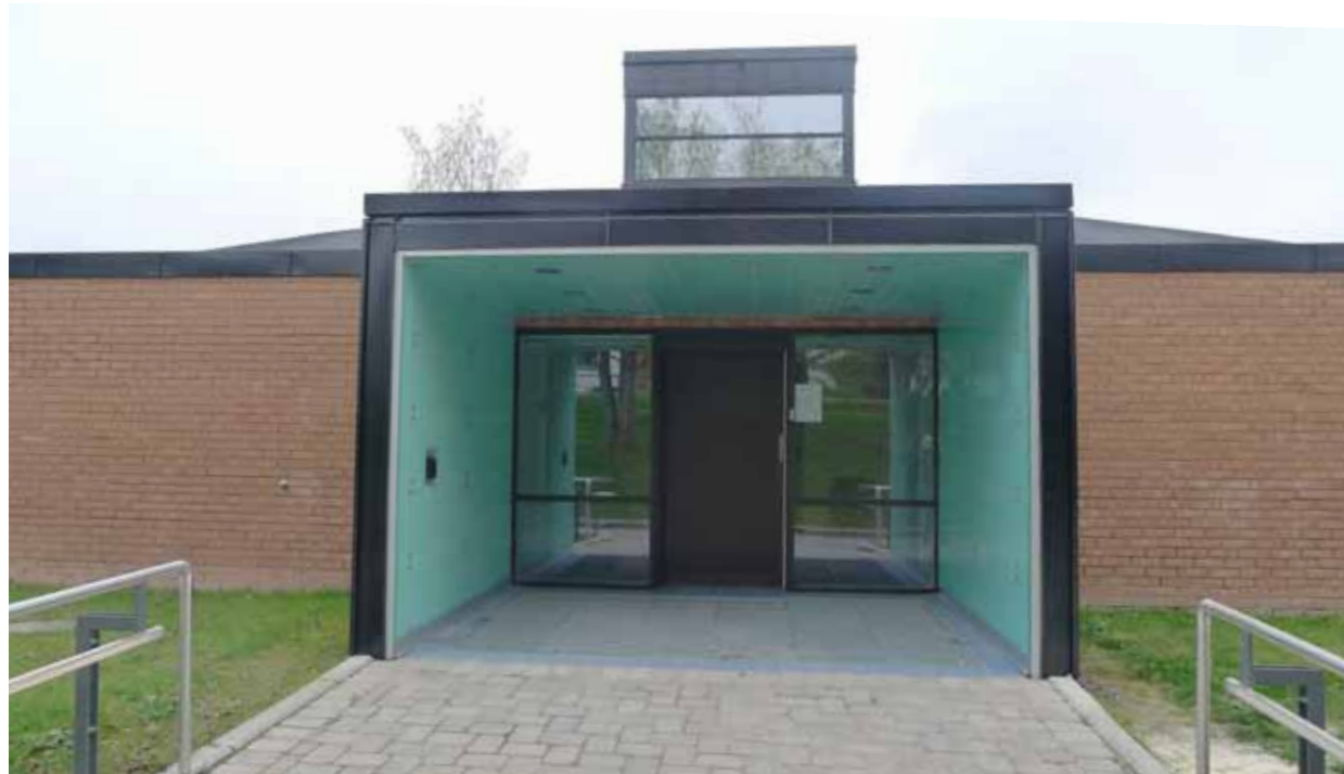
Elevhjem 1 - Sjøen - blågrønne glassplater - hamra glass (prikkete overflate) på venstre side og glatt glass på høyre side er taktilt orienterende. Lederekkverk føres frem til tablå på venstre side. Lydfyrtårn med hvalsang.
