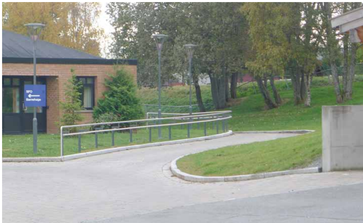
Lysmastene sørger for god belysning ovenifra, lederekkverket har lys i håndlistene, belyser bakken og synliggjør ledelinjen
