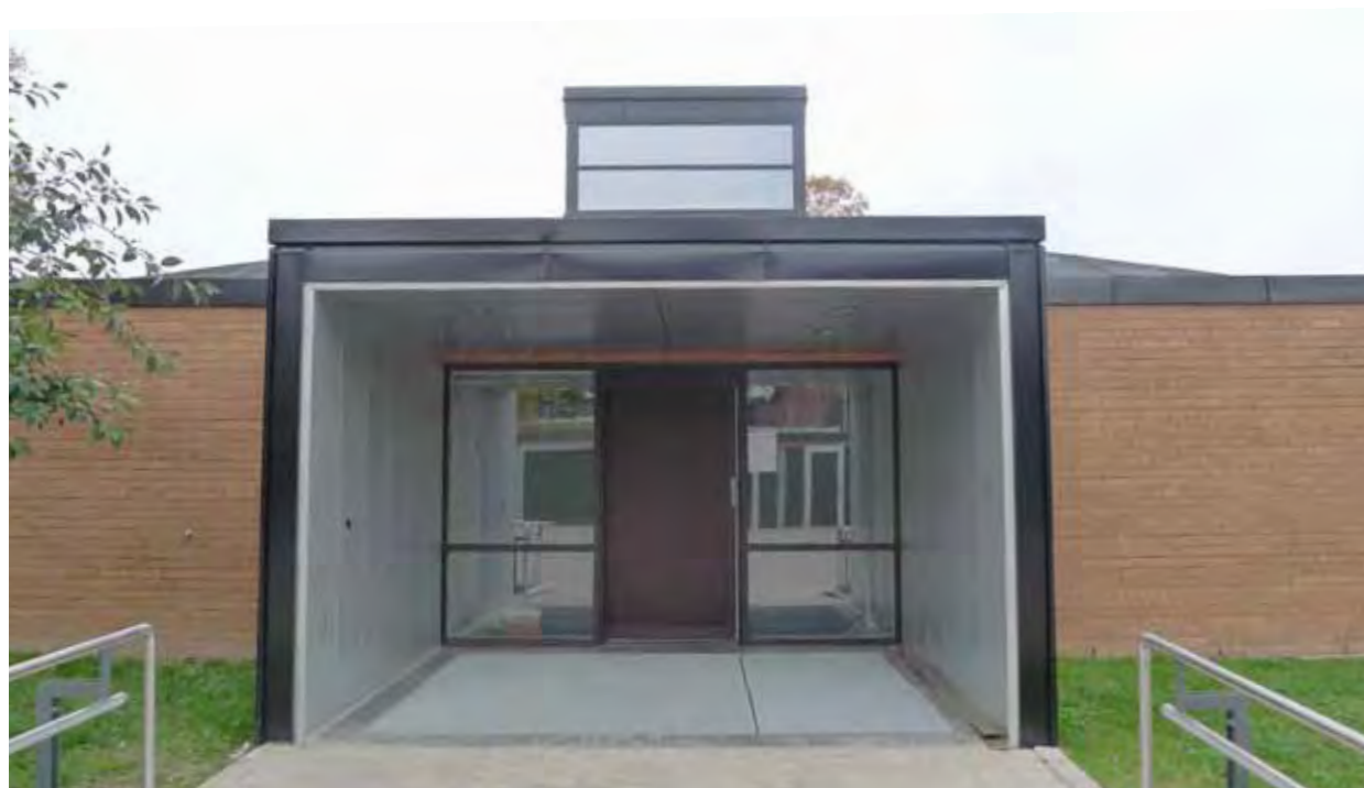
Elevhjem 3 - Fjellet - Sølv metallplater - delvis perforert for å gi ulik romklang og være akustisk orienterende. Lederekkverk føres fram til tablå på venstre side. Lydfyrtårn med vindsang.
