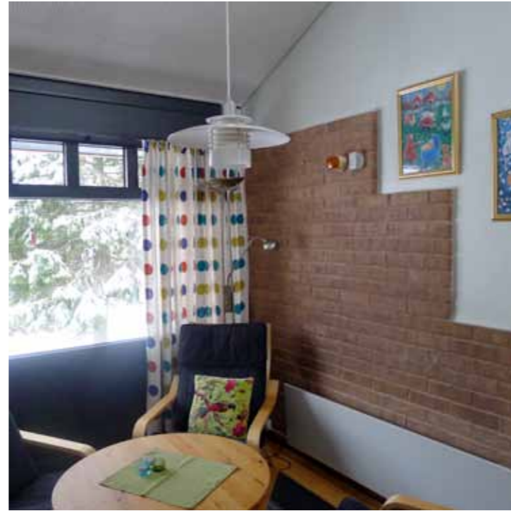
Felles oppholdsrom - Uheldig materialkontrast på vegg. Uheldig fargekontrast på vindusspross
