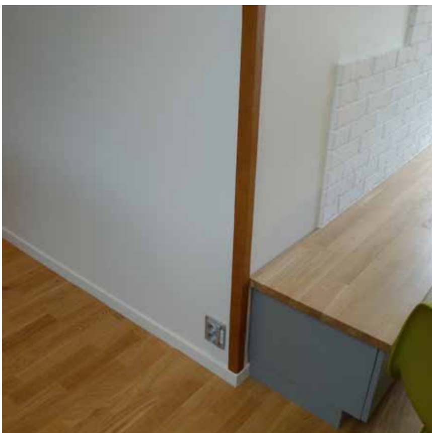
Vegghjørnet er markert med en skintrukket metallist som er taktil og gir et mykt og hjemlig preg
