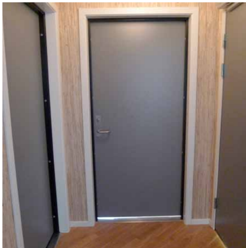
Inngang til hyblene har samme materialkvalitet som hovedinngangen. Strågul havretapet er orienterende med taktilitet, raslende lyd og akustisk demping. Annen himling og dermed annen romklang.
