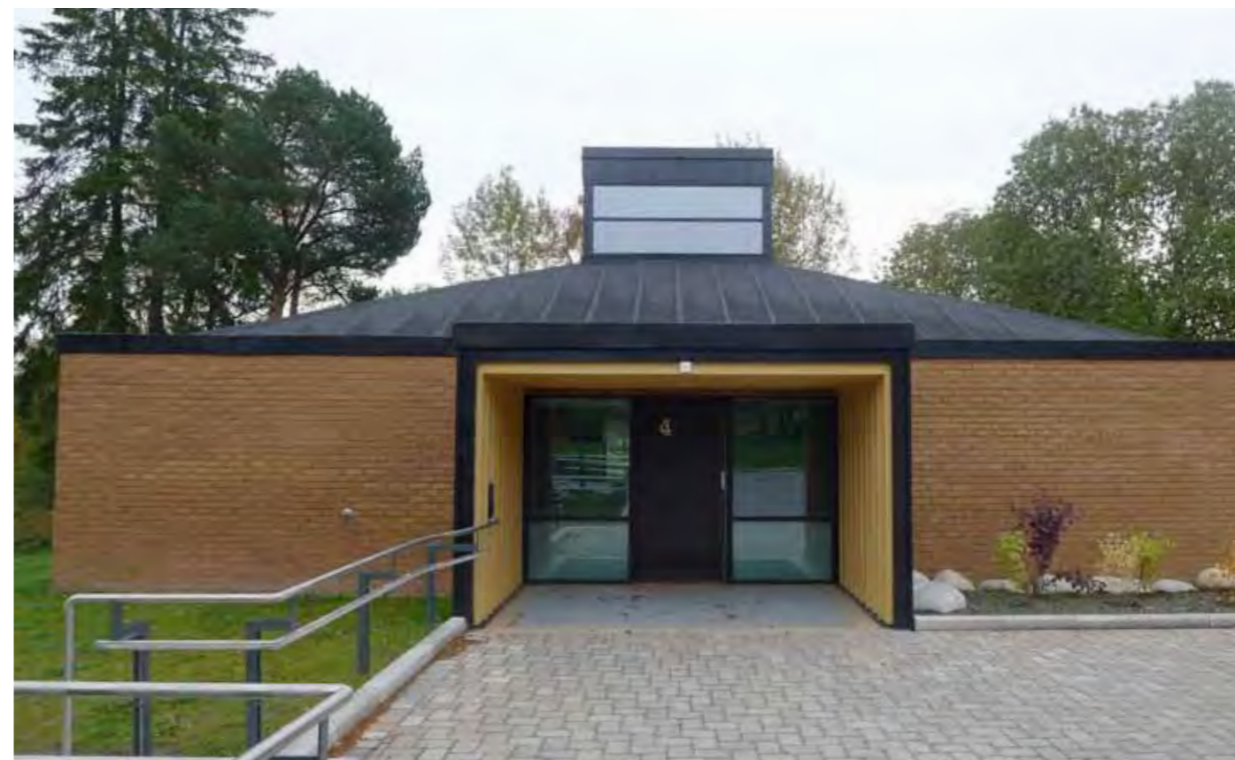
Lederekkverk leder hjem - fram til adgangstablå - ringeknapp og adgangskontroll. Lydfyrtårn i himling kan iverksettes med feks. fuglesang
