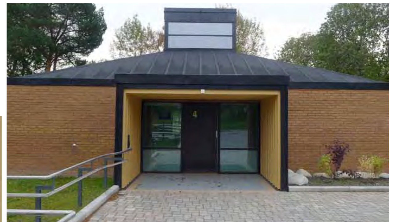
Elevhjem 4 - Skogen - gyldent treverk med akustisk demping på venstre side er orienterende. Lederekkverk føres fram til tablå på venstre side. Lydfyrtårn med fuglesang.
